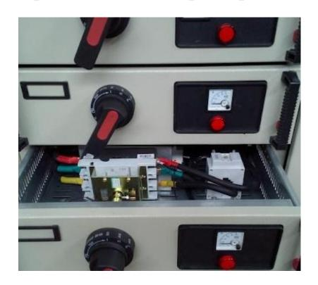
(4) Блок управления питанием и освещением. Большинство из них являются закрытыми вертикальными установками. Из-за
